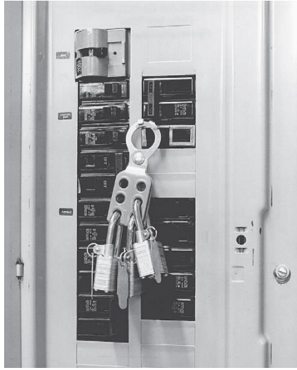
شكل رقم ٢٢: نظام اغلاق لدوائر وتوصيل الكهرباء
